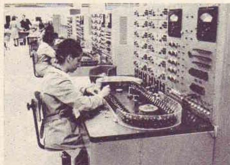
Nello stabilimento RCA-ATES di Catania per la produzione di semiconduttori, sono applicati i criteri più progrediti, sulla base di una tra le più probanti esperienze, quella degli analoghi stabilimenti RCA americani. Ecco una serie di banchi automatici di collaudo con i quali vengono controllati tutti indistintamente i transistori prodotti.
